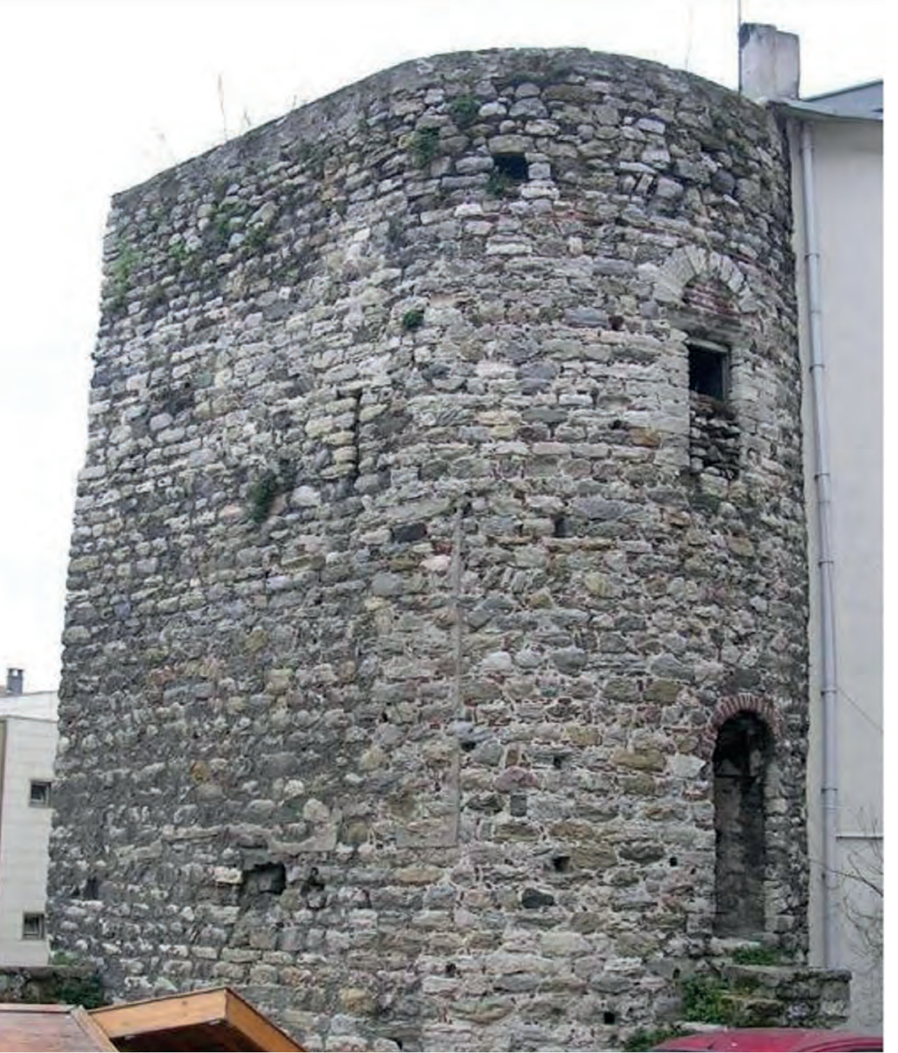
9 No'lu Burcun Kuzey Cephesi
