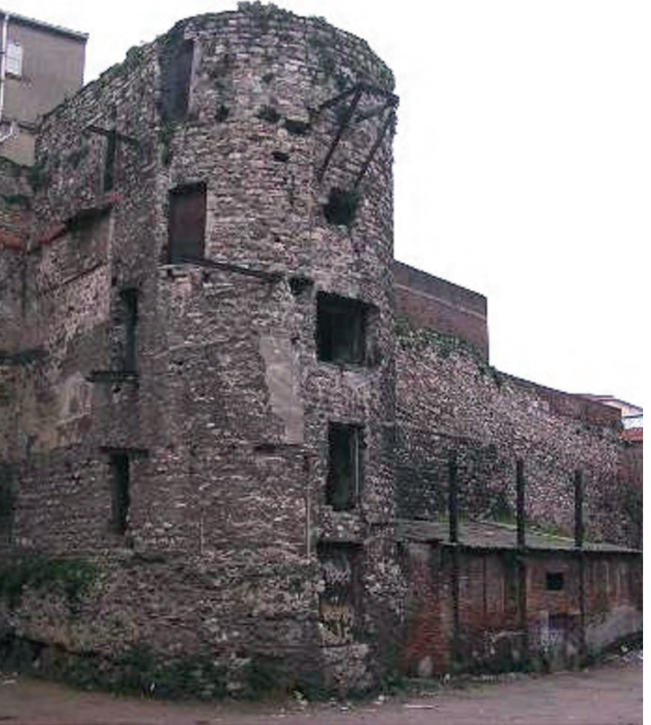
16 No'lu Burç Kuzey Cephesi Görünümü - 1
